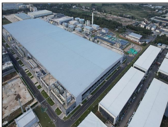
4#电池车间现状影像
