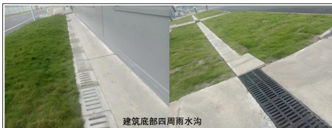
图 5.4-1 已实施排水沟现状影像
