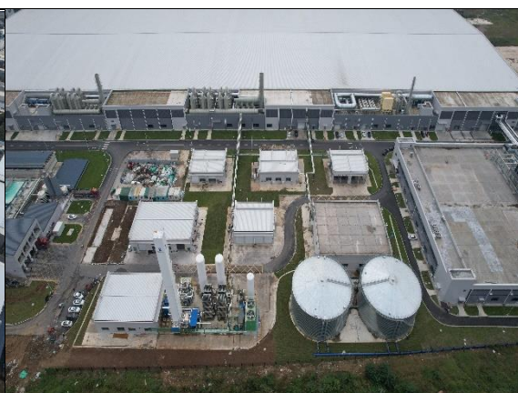
室外水罐及附属罐区现状影像
