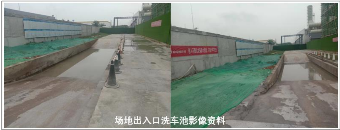
图 5.4-6 已实施洗车设施过程影像
