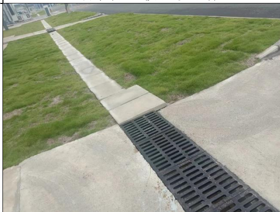
项目区排水沟及草籽绿化现状
