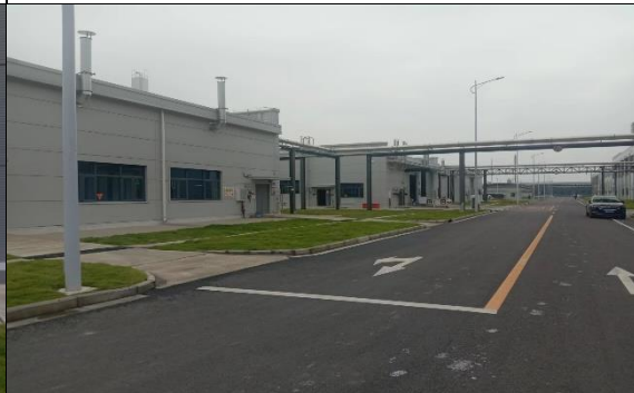
项目区道路硬化及草籽绿化现状
