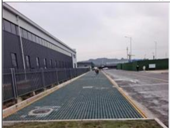
项目区透水铺装车位现状影像
