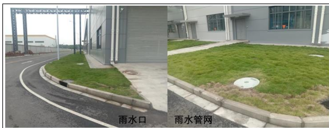
图 5.4-3 已实施雨水口、雨水管网现状影像
